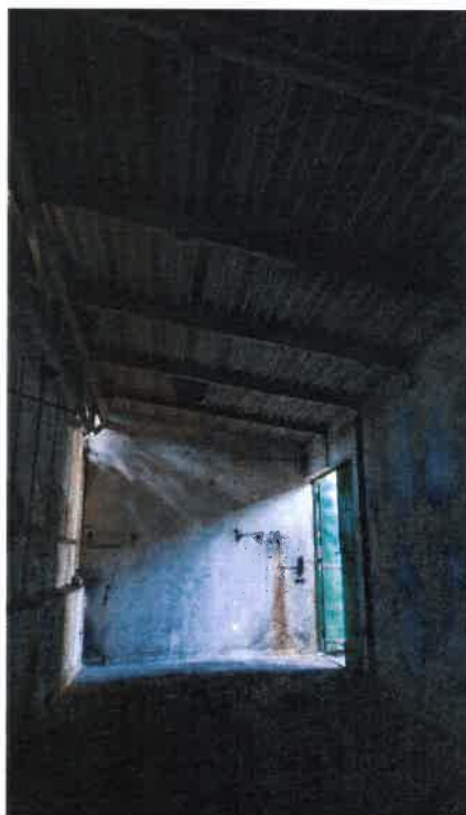
Přístavek – plynová kotelna
