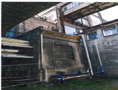
Přístavek – vstup do energokanálu
