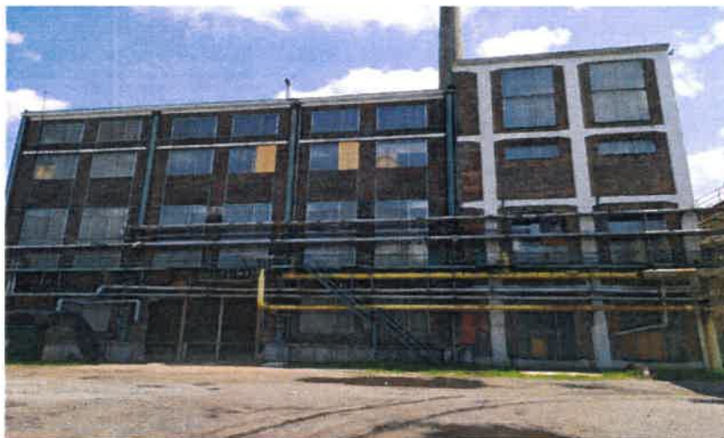
Stavba kotelny I na pozemku parc. č. 1522/52 v k.ú. Lazy u Orlové
