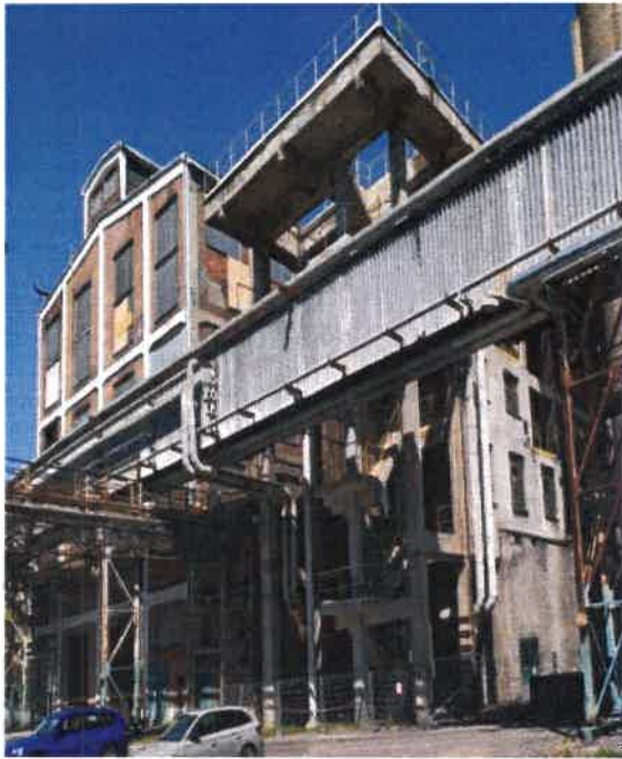
Železobetonová konstrukce býv. elektroodlučovačů
